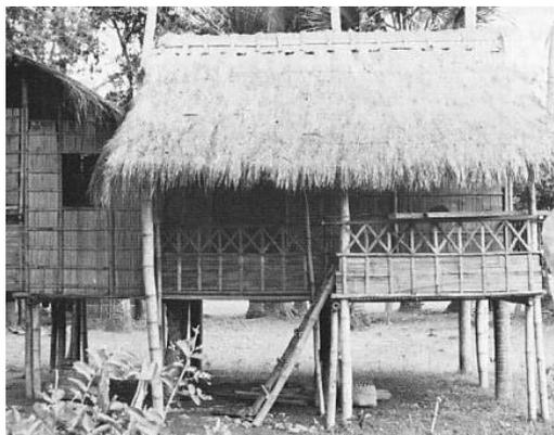
Figura 13 – Elementos de fundação apoiados diretamente no solo
