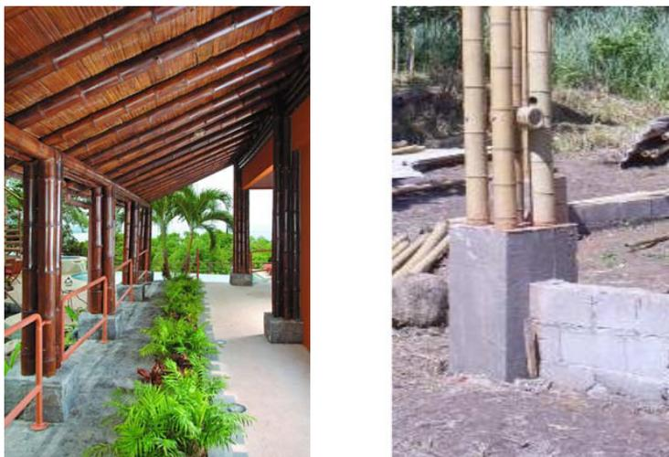
Figura 14 – Fundações em forma de sapatas de concreto
