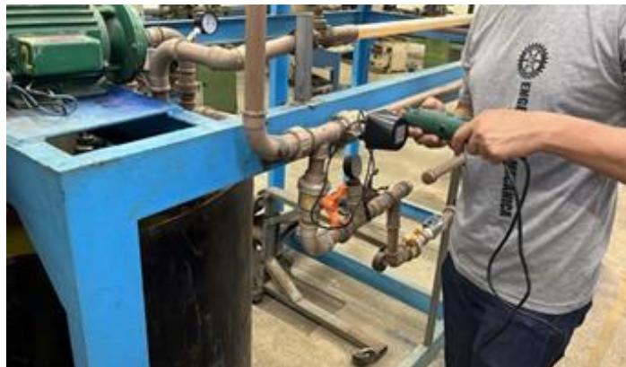
Figura 16 - Instalação de atuador elétrico.
