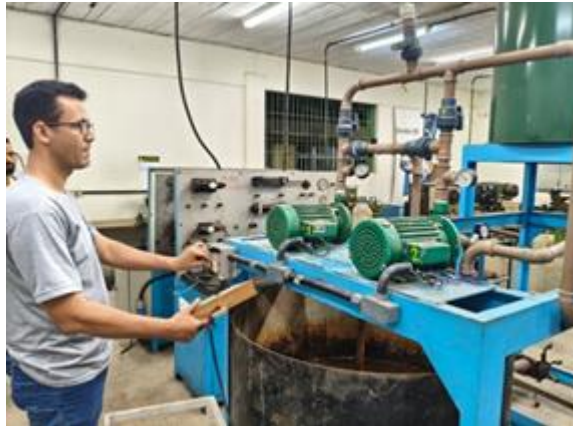
Figura 15 - Teste do sistema elétrico.
