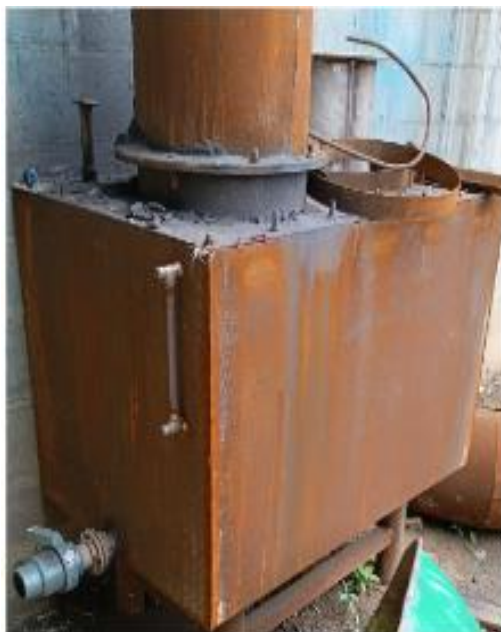
Figura 9: Caixa de armazenamento de água
